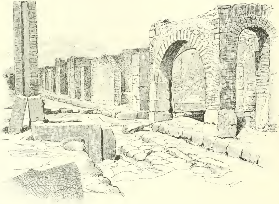
Rue de Stabies.
